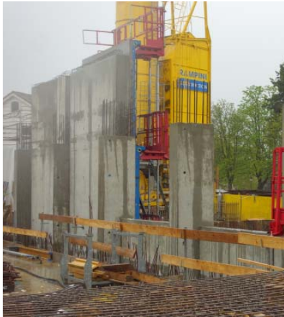
Pendant les travaux
