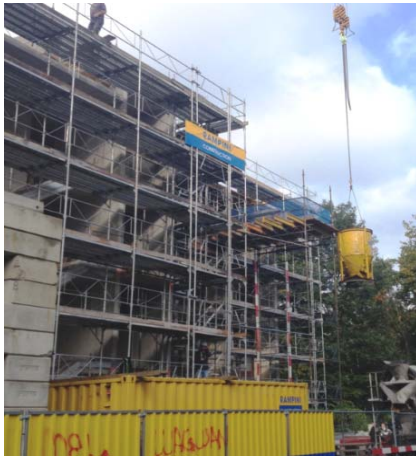
Pendant les travaux
