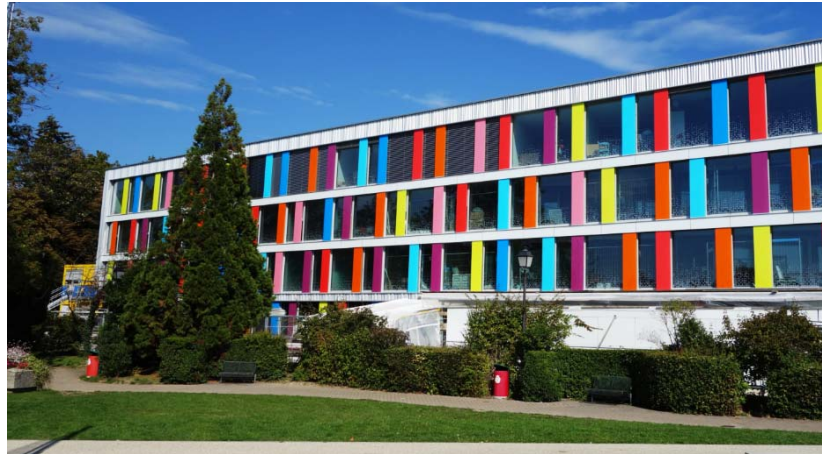
Après les travaux
