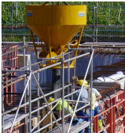
Pendant les travaux
