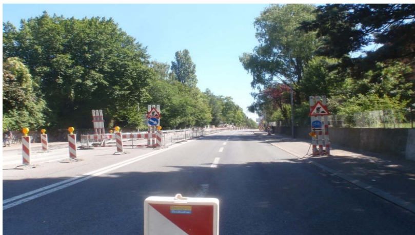
Raccord des sacs sur chaussée
