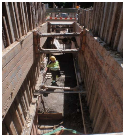
Réalisation du collecteur
