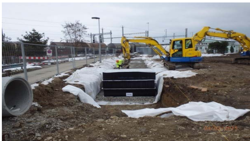
Construction bassin de rétention et infiltration
