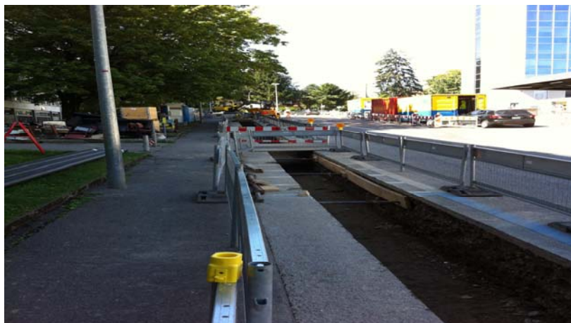
Pendant les travaux
