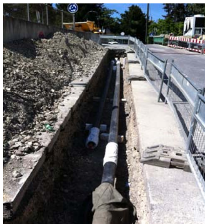
Pendant les travaux
