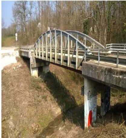
Pont avant les travaux
