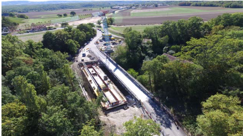
Pendant les travaux
