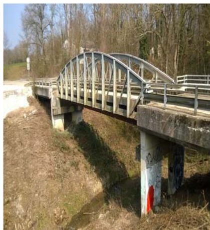
Pont avant les travaux
