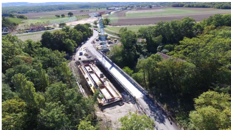
Pendant les travaux
