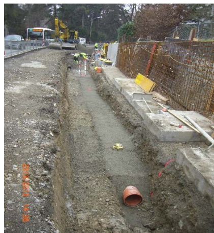
Construction de réseaux
