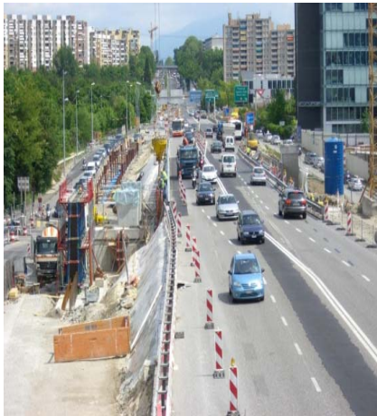
Pendant les travaux
