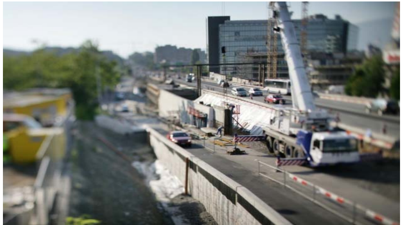
Pendant les travaux
