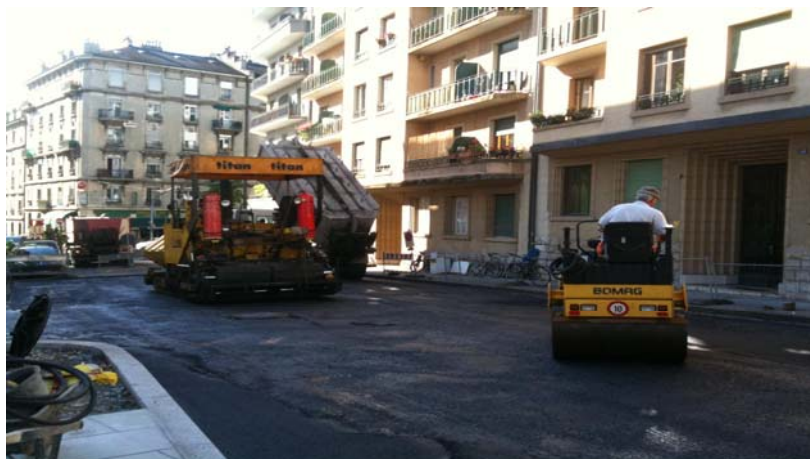
Pose des enrobés bitumineux des couches de support
