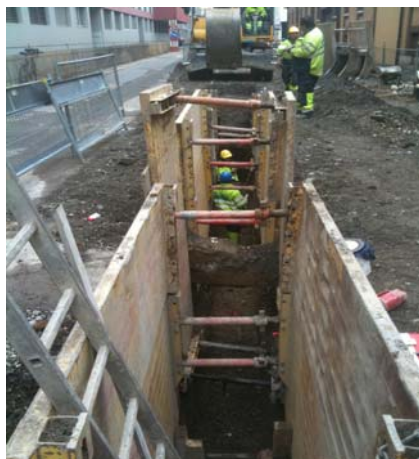
Travaux de collecteurs avec blindage Krings
