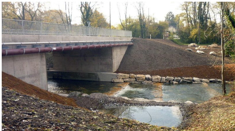
Après les travaux, pont reconstruit
