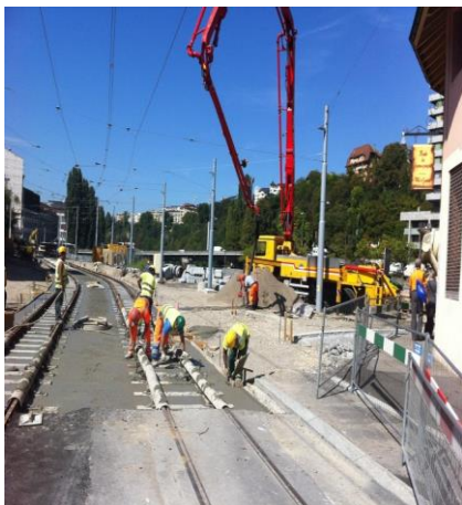
Bétonnage des rails
