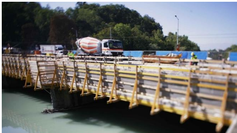
Pendant les travaux
