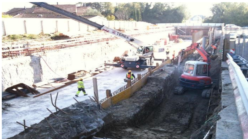
Recépage tête de paroi moulée et construction de la dalle intermédiaire
