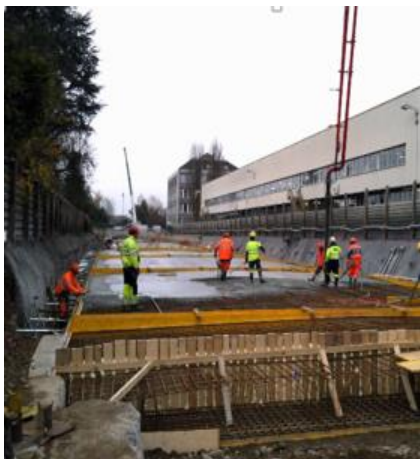
Construction de la dalle de couverture
