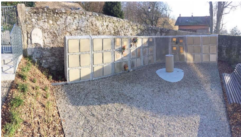
Après les travaux
