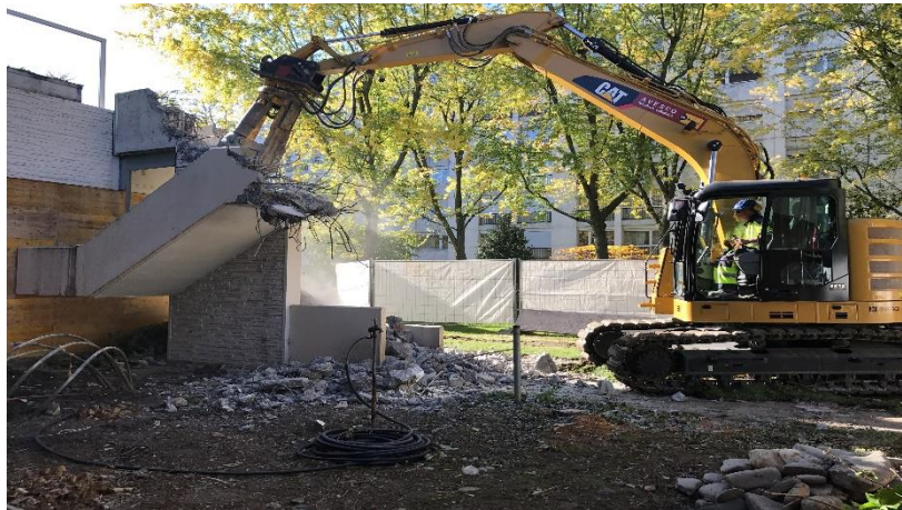
Pendant les travaux de démolition
