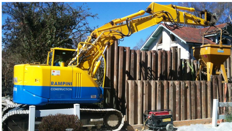
Bétonnage des collecteurs
