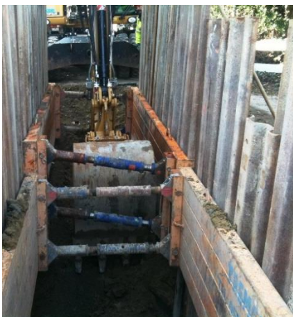
Fouille avec blindage palplanche + Gigan
